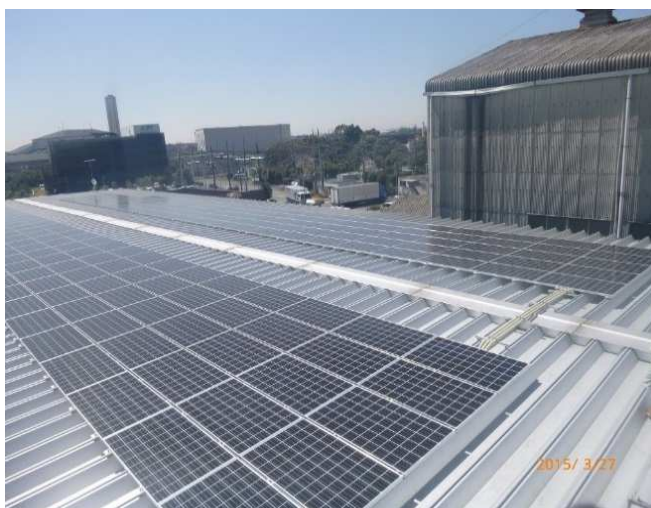
太陽光発電設備
