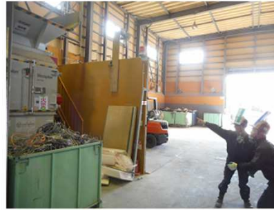
4-1) 火災状況確認
